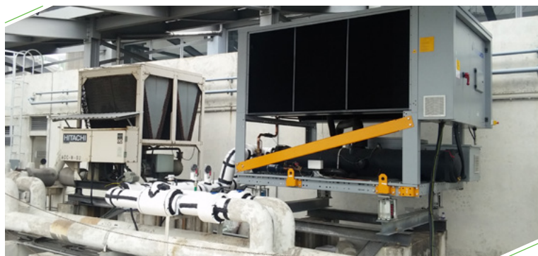
◀ Oil-free chillers 无油磁浮式制冷机
